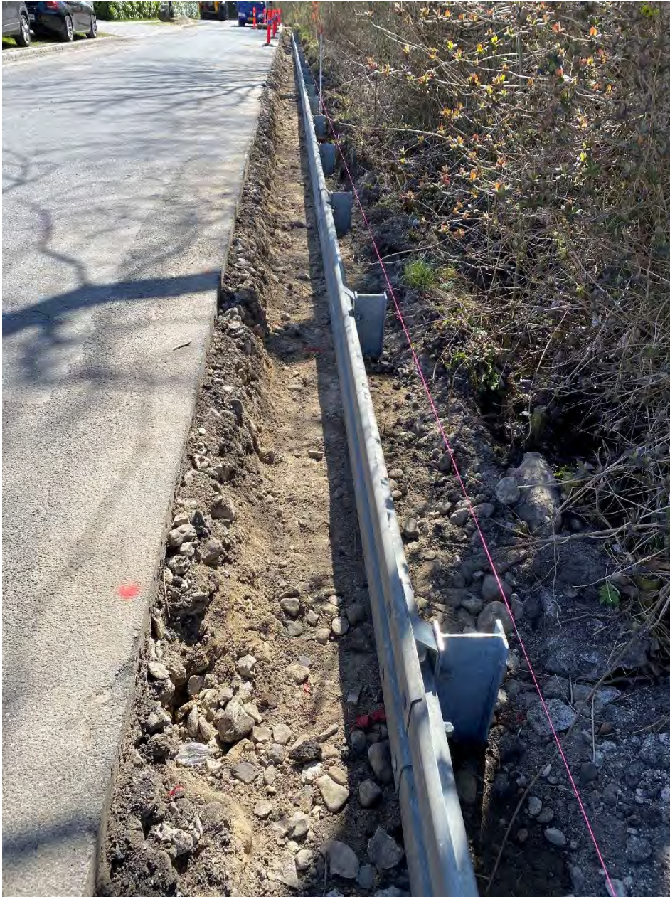
På I-profilerne monteres autoværnsplader.
