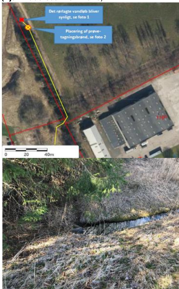
Figur 3. Øverst) Udløbsledningens forløb til målebrønd/prøvetagningsbrønd og videre til udløbspunkt i Sideløb til Kajerød Å, hvor vandløbet går fra rørlagt til åbent vandløb (vist med rødt kryds). Nederst) Udløbspunkt for udløbsledningen umiddelbart øst for udmundingen af det rørlagte vandløb i den åbne del af Sideløb til Kajerød Å.
