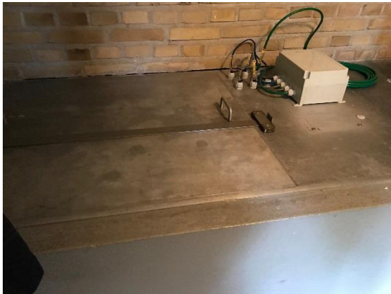
Figur 9: Nedgang til rentvandstank
