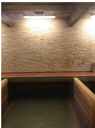
Figur 3: Åbne sandfiltre
