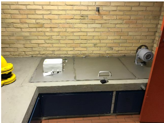
Figur 5: Nedgang til rentvandstank
