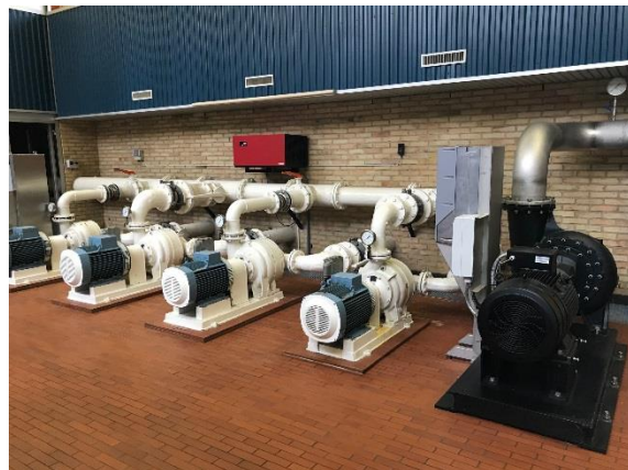
Figur 6: Skylllevands- og rentvandspumper
